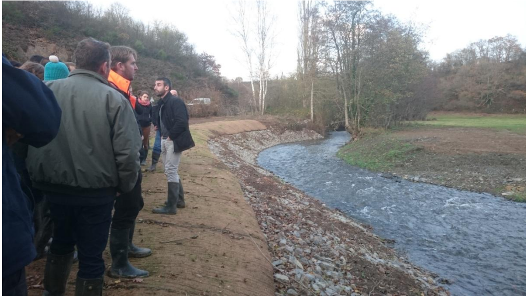
Photo du site du Danet après l'arasement du seuil
