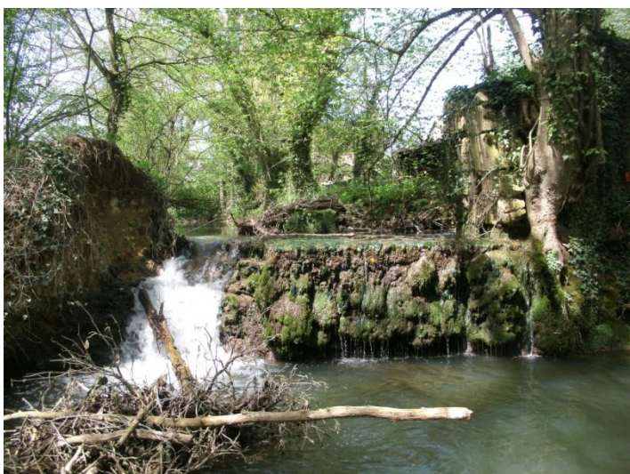
Exemple d'un ancien seuil de moulin infranchissable pour la faune piscicole sur le cours de la Senelle
